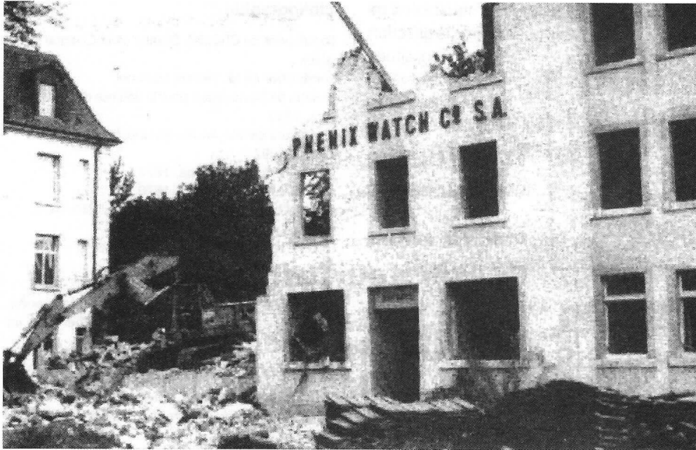
Démolition des bâtiments, Le Pays , 23 août, 1984.
